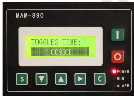
16. Praca i przerwy sprężarek w sieci
